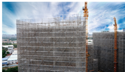
园区二期建设实景图
